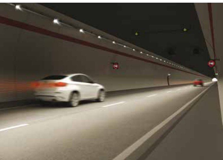
1. Il sistema di illuminazione permanente
