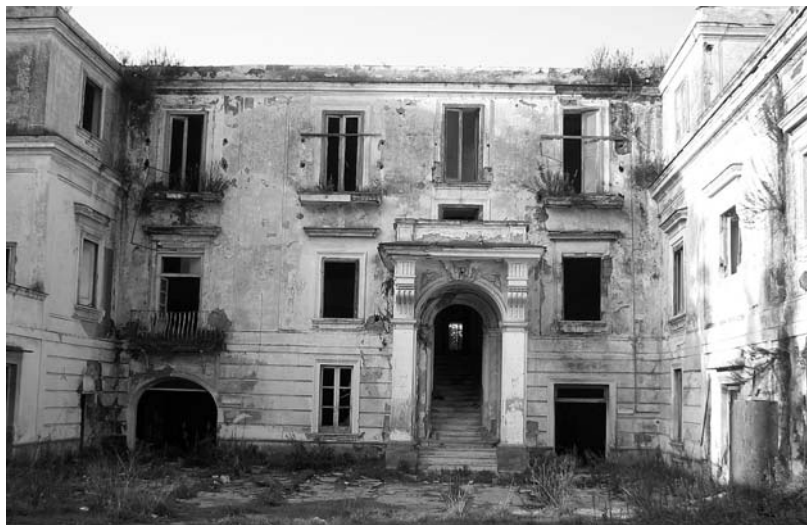
FOTO 24 - Lo stato attuale della struttura di Ponticelli
